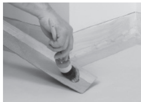
Levitä liimaa lattialle ja seinää vasten viivan kohdalle.
